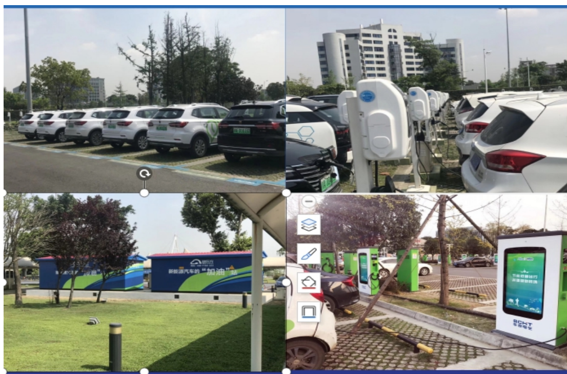
图 11 双流机场陆侧停车场充电设施
