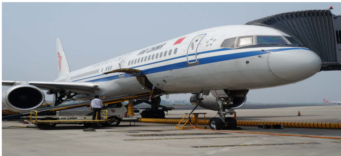
图 4 双流机场廊桥机务岸电设施保障航班
