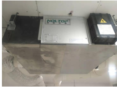
图 29 具有 PM2.5 电子除尘过滤的室内机
