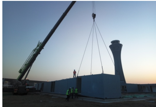
图 22 箱体现场吊装作业
