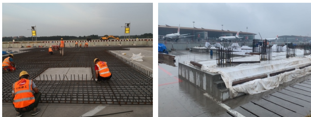
图7 创新工法基础作业
