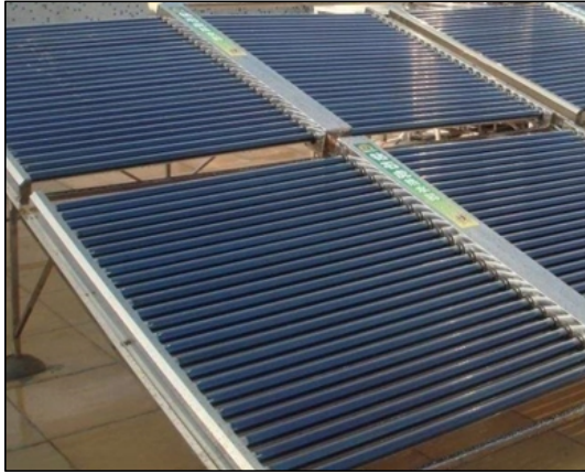
图 32 太阳能热水设备安装图
