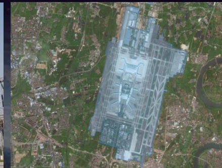
周界安防全域监控
